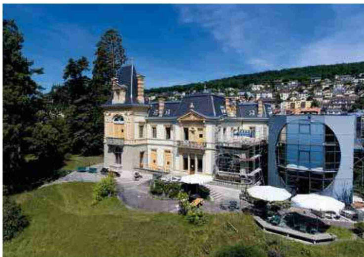
La Villa de Pury a nécessité d'importants travaux de restauration.
