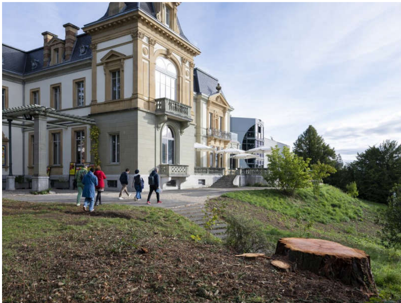
Les travaux de réhabilitation du parc du Musée d'ethnographie viennent de commencer. Photo: Lucas Vuitel
